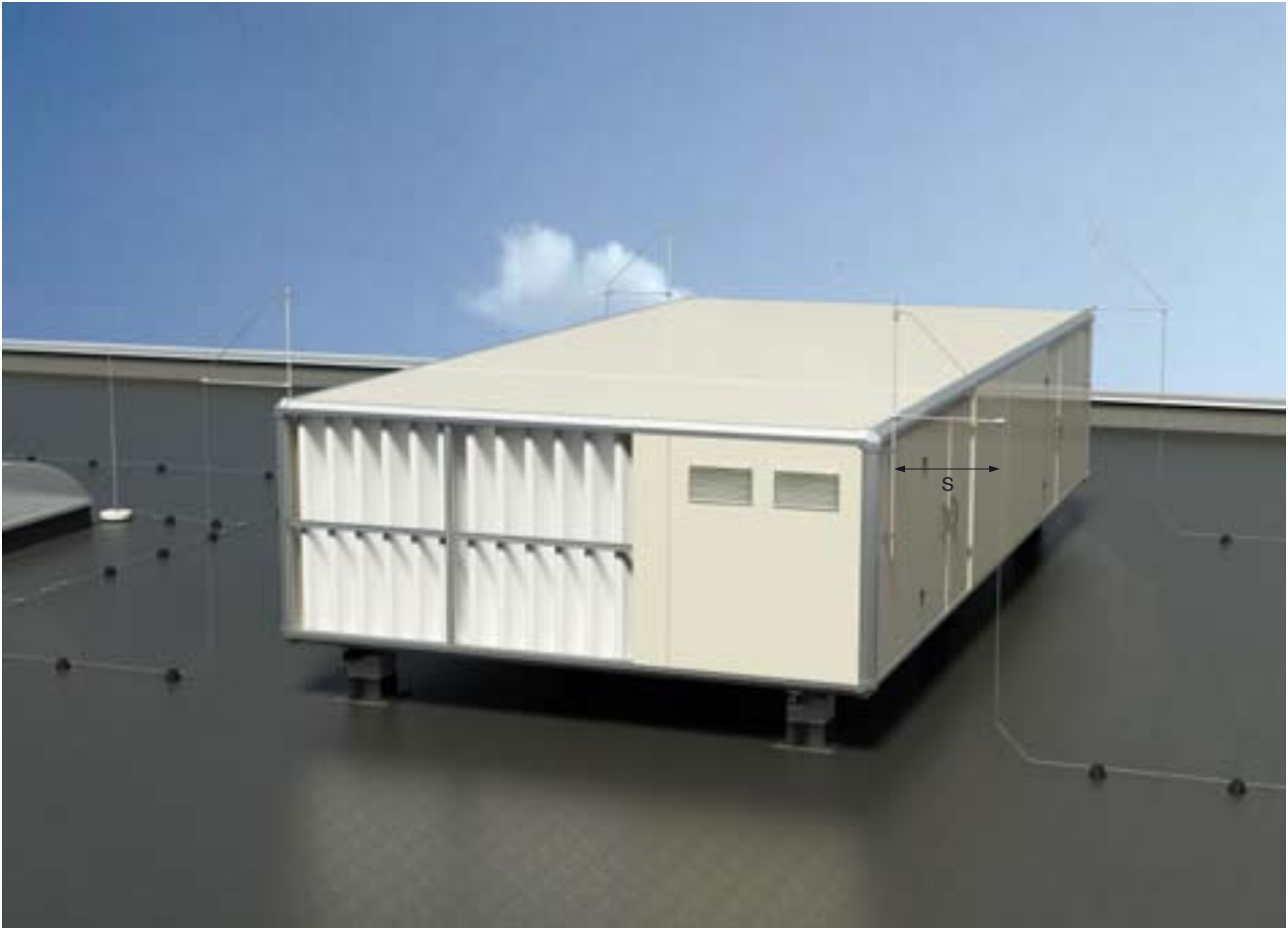
Isolierte Fangeinrichtung mit Trennungsabstand (s)
