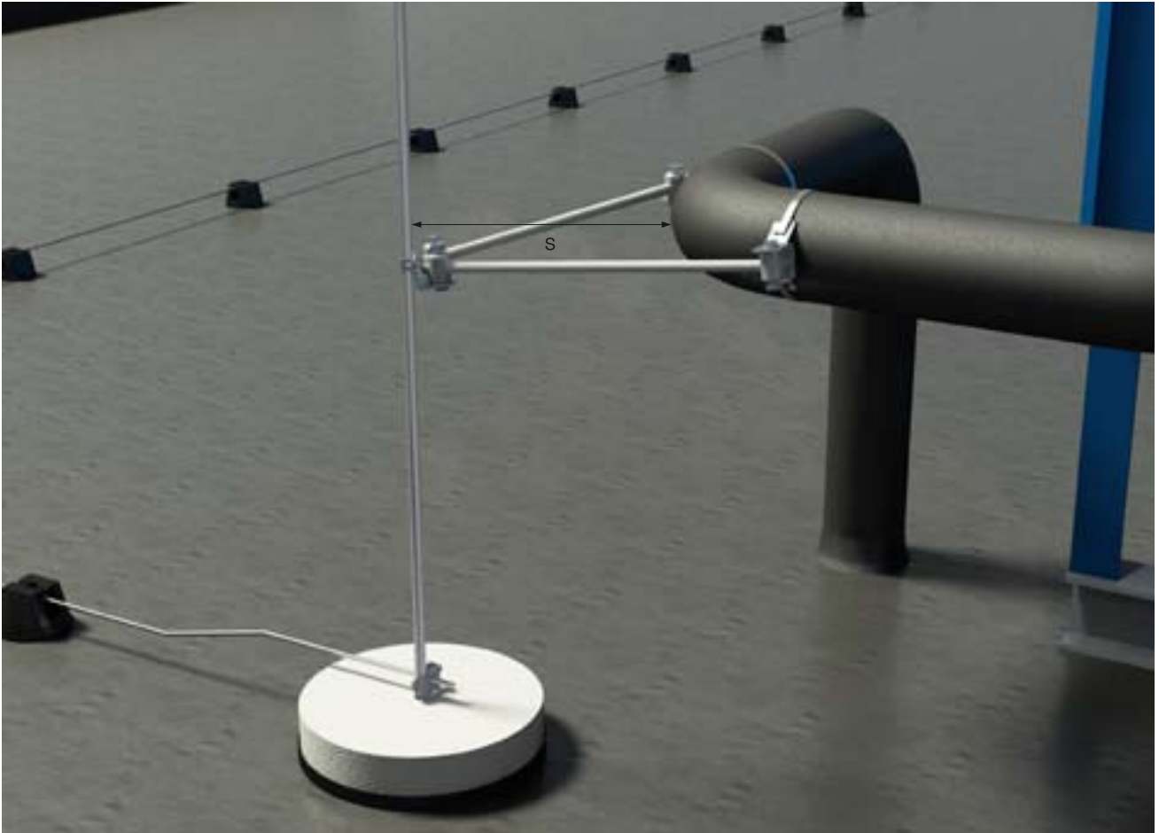
Fangstange mit Iso-Combi-Set und Trennungsabstand (s)
